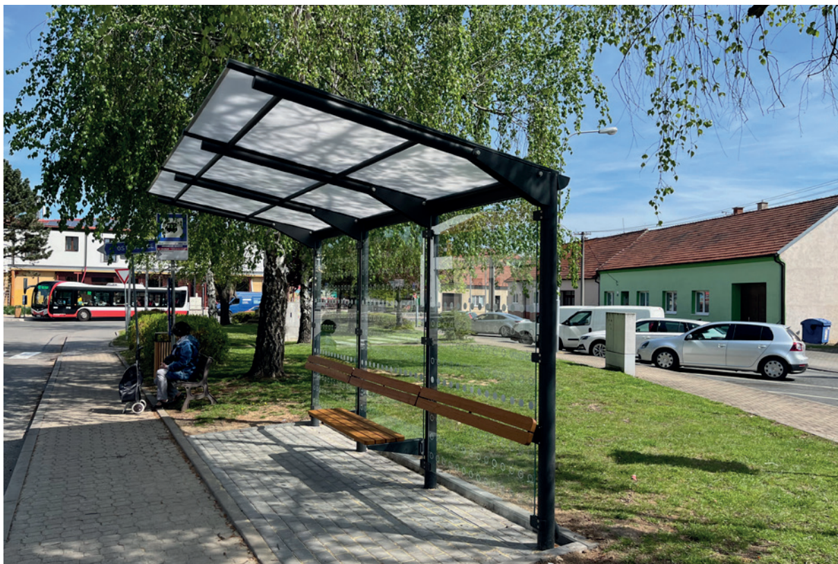
třímodulový přístřešek bez bočnic, uprostřed lavička, v krajových modulech pouze opěrák
