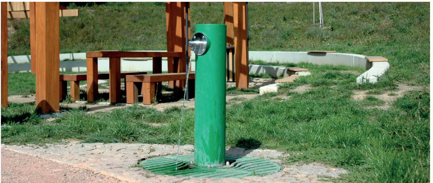
Tlakový ventil je připevněn na leštěné nerezové desce.
