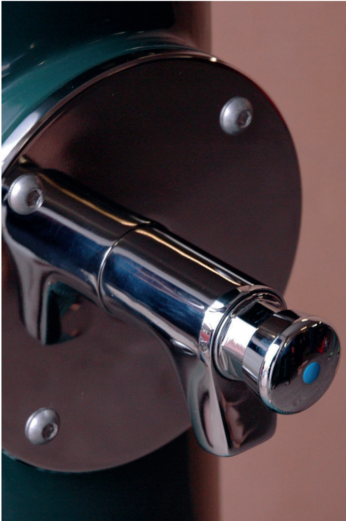
Pítka jsou vybavena tlakovým ventilem. Voda po stisknutí tlačítka po určitou dobu teče a následně se sama zastaví.
